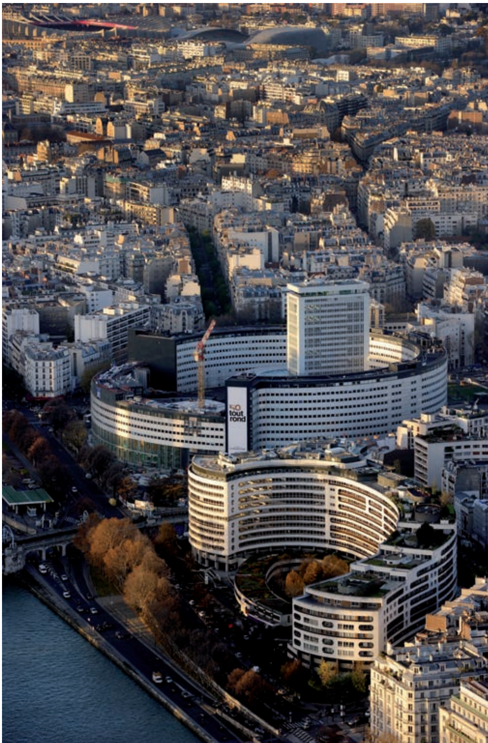
Vue aérienne de la Maison de la Radio
