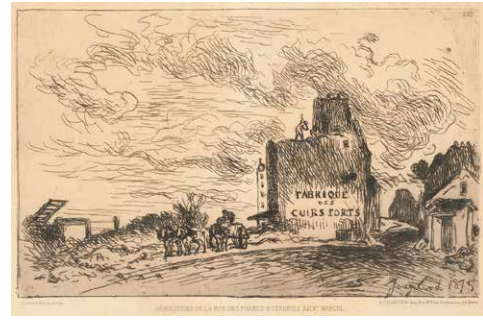
157. Johan Barthold JONGKIND (1819-1891) Démolitions de la rue des Francs-Bourgeois Saint-Marcel. 1875. Eau-forte. À vue : 29,5 x 42,5 cm. Delteil 18 (iii / iv). Belle épreuve sur vergé crème, du tirage Cadart. Légères salissures, traces de plis et quelques petites rousseurs. Toutes marges. Cadre. 200 / 300 €
