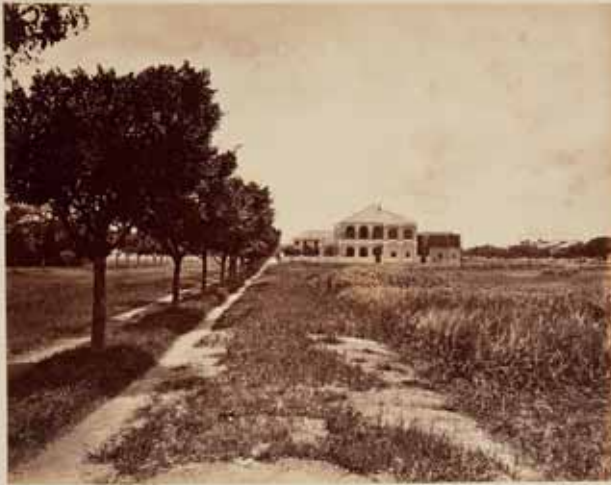
CANTON. Le Palais de l'Exposition. Le Palais de l'Exposition de Canton, construit par les Français, pendant la guerre de l'opium.
