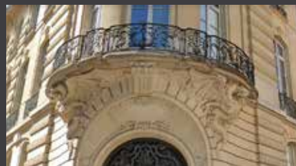
Immeuble édifié par Paul-Antoine-Fleuri FARGE en 1927, à l'angle des rues des Mathurins et d'Anjou, à Paris, dans le VIII e arrondissement.
