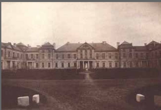
Vue extérieure du palais de Wichniowecz, résidence du prince Paul Démidoff.
